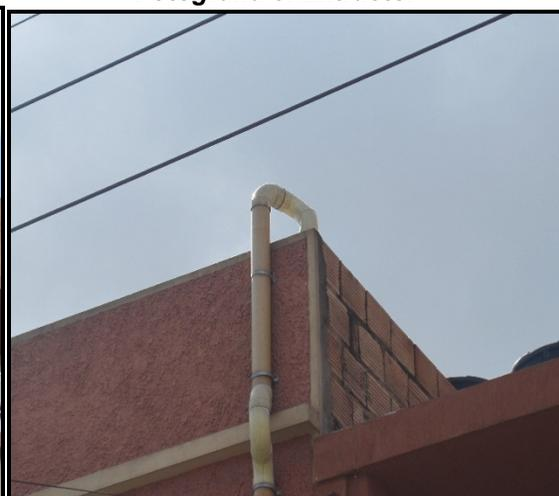
**Fotografía 4 y 5. Ducto del sistema de extracción de la cortadora laser**
